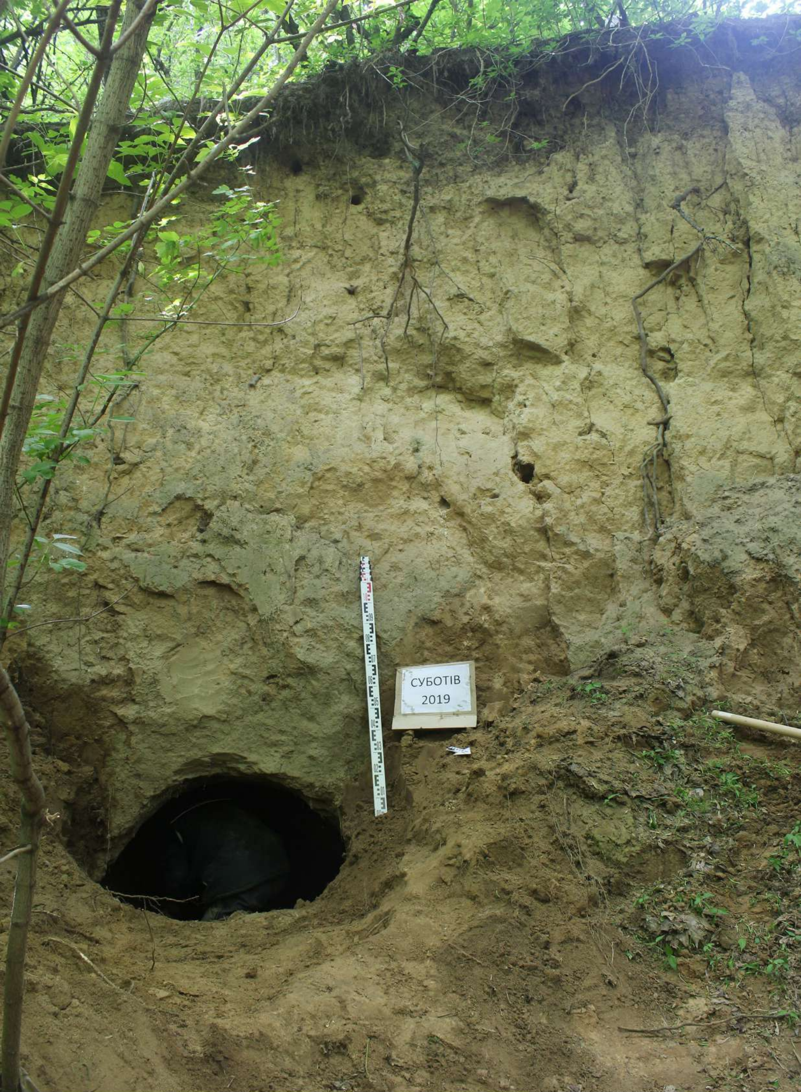
Рис.14. Вхідний отвір до об'єкту №3. Фото.
